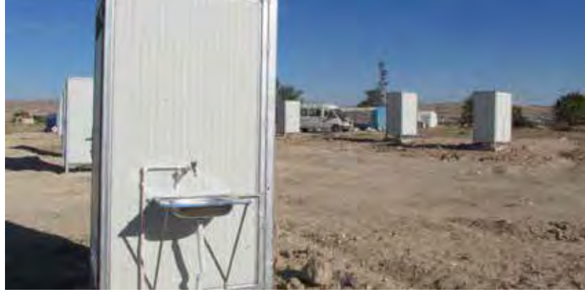
METİP kapsamında yapılan ve kullanılmayan tuvalet ve banyolar (9 Eylül 2013, Eskişehir-Alpu)
