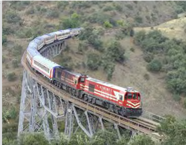
Bandırma-Izmir Demiryolu Hattı
