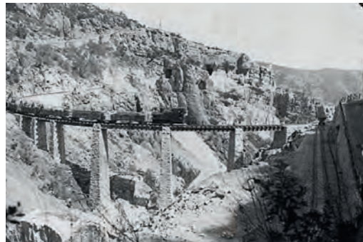
Toroslarda Bağdat Demiryolu Viyadüğü
